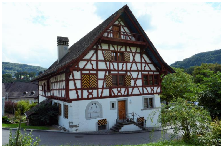
Nordfassade mit Klappladen eines ehemaligen Verkaufslokals. Heute befindet sich in diesem Raum ein Lager und eine kleine Werkstatt für das Museum.
